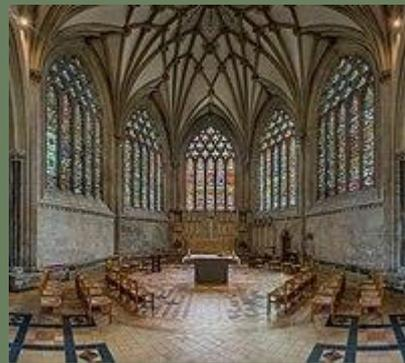
Podemos observar, principalmente, la utilización del arco apuntado, distintivo de la arquitectura gótica, que reemplazó al arco de medio punto del románico. Es más esbelto y ligero, al ser resultado de la intersección de dos secciones de círculo, permitía estructuras más altas al transmitir tensiones laterales menores. Variaciones como el trilobulado se desarrollaron durante diferentes períodos góticos.
